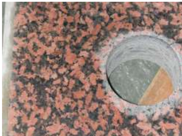
Kuva 1. Luonnonkiviohuttaattapintainen koekappale, josta on porattu näyte tartuntavetokokeeseen.
